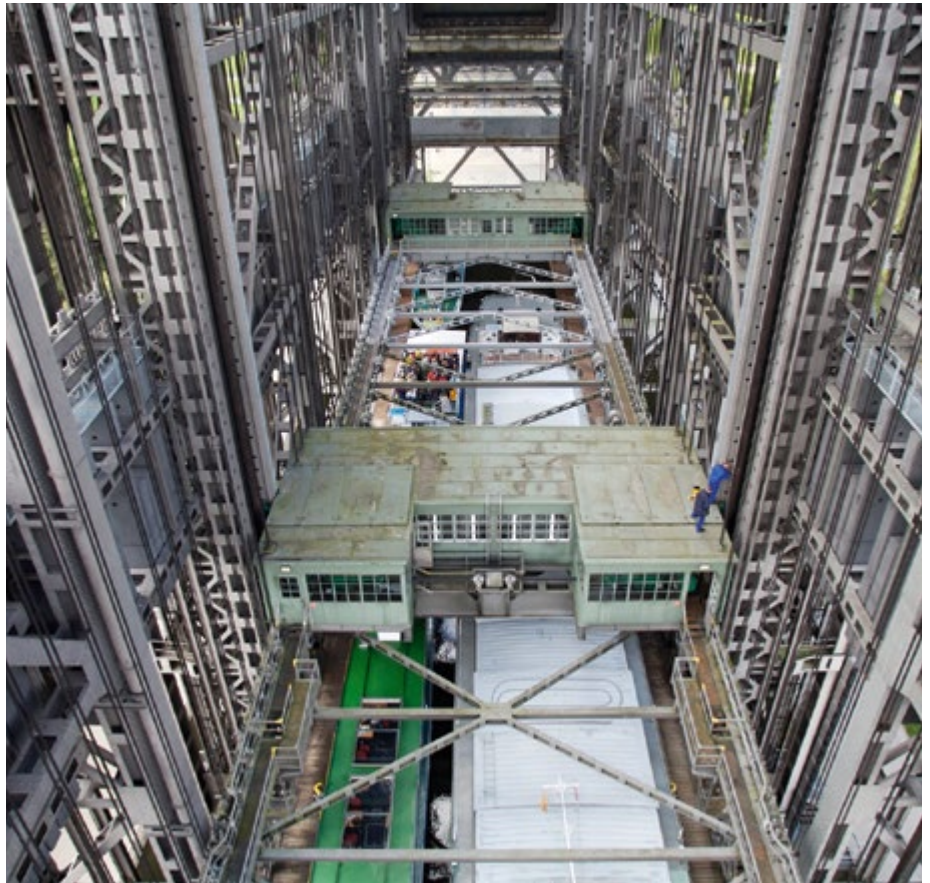
Industriedenkmal, Filmkulisse und kritische Infrastruktur für die Binnenschifffahrt mit Polen und zur Ostsee – das Schiffshebewerk Niederfinow.
